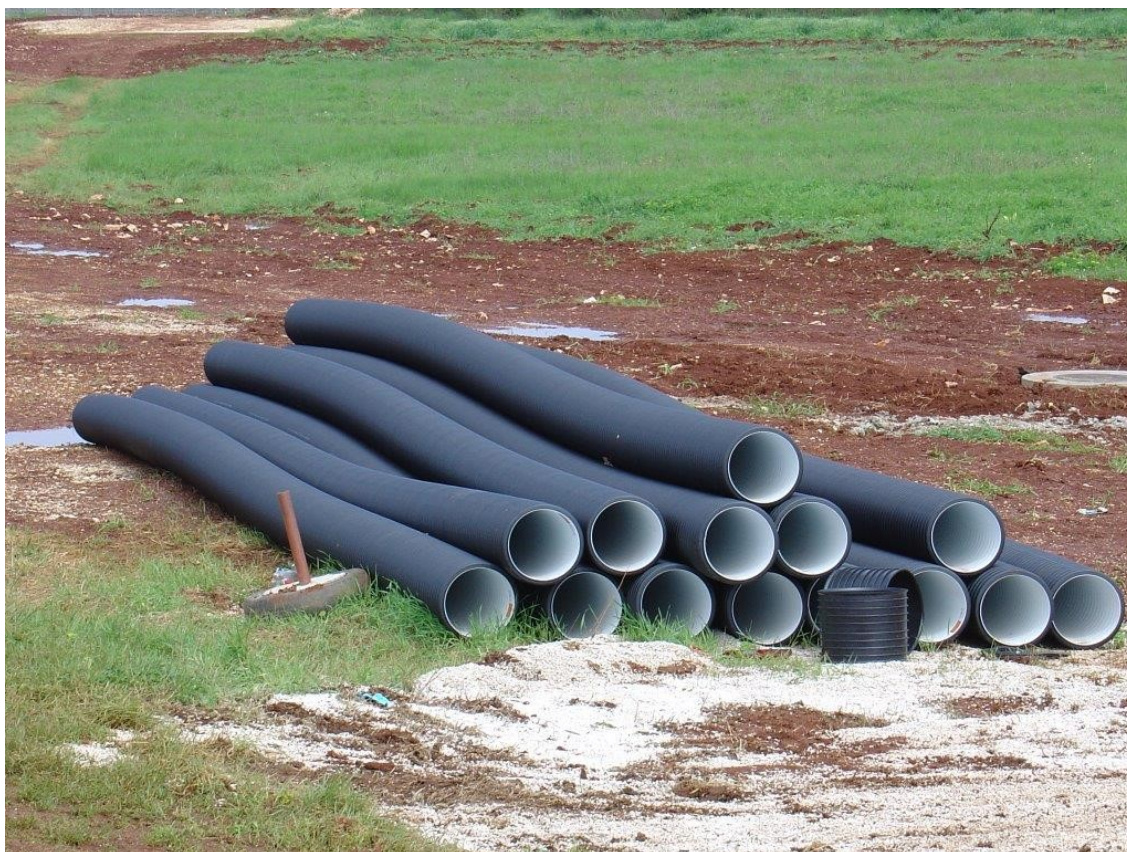
Slika 6-7 Prikaz uzdužne deformacije deponiranih cijevi
