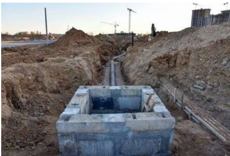
Slika 8-3 Monolitna AB crpna stanica
