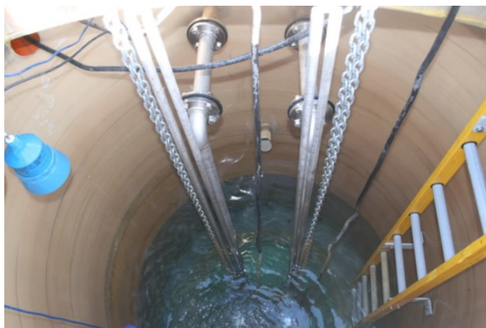
Slika 8-1 Unutrašnjost predgotovljene GRP crpne stanice
