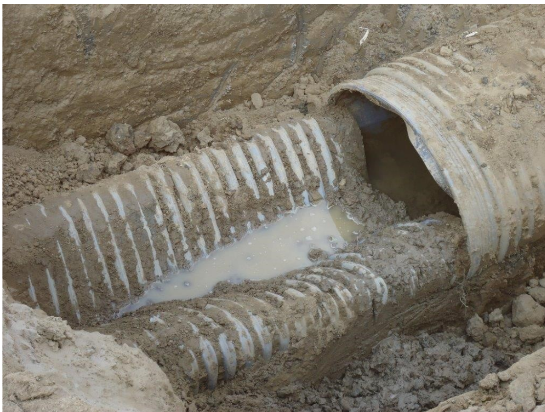
Slika 6-5 Prikaz puknuća cijevi male tjemene nosivosti
