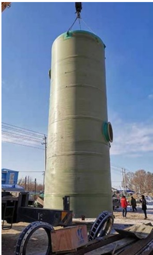
Slika 8-2 Predgotovljena GRP crpna stanica
